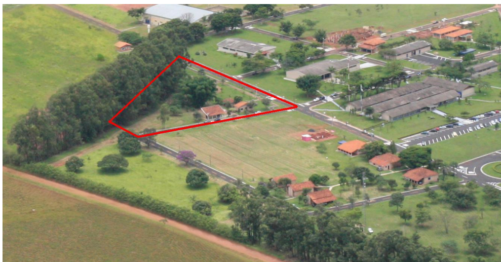
Figura 3 - Fotografia aérea destacando, em vermelho, a área onde ocorreram as atividades dentro do Campus do IFTM
