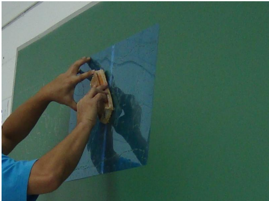
Figura 3 – Aplicação de pó de giz sobre toda a superfície do gabarito.
